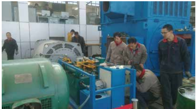
● 稀油站强油供给2级轴瓦出厂试验
