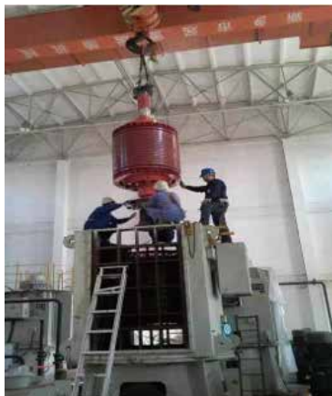
● 河北建投任丘电厂YKSL 1950-12/1500-1950KW循环水杯电机端环加固、导条焊接
